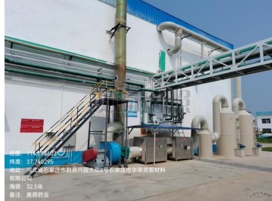
DA001 全套处理设施+15 米排气筒
