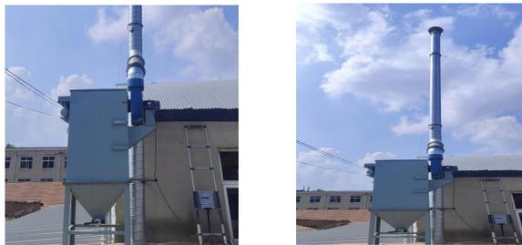
图 4-1 布袋除尘+15 米排气筒
